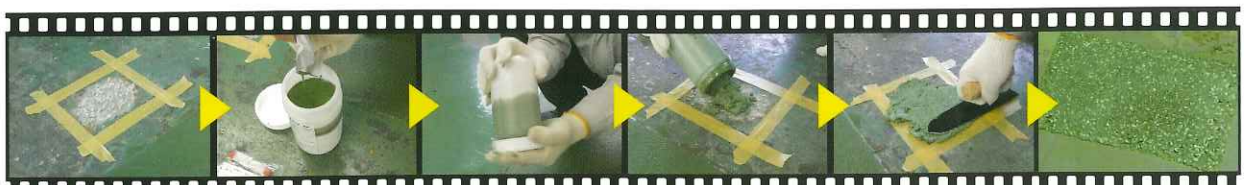
①施工する箇所を養生
