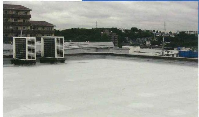
アトレーヌ水性トップは、特殊変性アクリルエマルションを主成分とし防水のトップコートとして開発された水性塗料です。従来の防水層保護用水性トップコートに比べ、密着性、耐久性に優れ、作業性も良好な塗料です。
