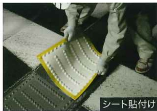
シート貼付け
